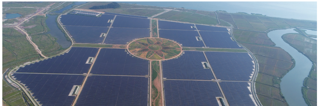
솔라시도 태양광 발전 사업 현장 전경
