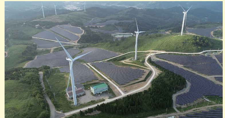
영암태양광 발전사업 현장
